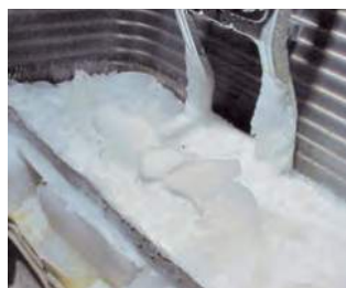
Oblodzenie urządzenia zewnętrznego bez ogrzewania tacy
